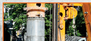
Drilling foundation/ perforazione per fondazioni
